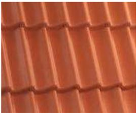
Die Dacheindeckung erfolgt mit BRAMAC-Donau-Dachsteinen in Rubinrot. Die Unterkonstruktion wird mit Traglattung und Konterlattung belüftet ausgeführt. Der First wird belüftet in mörtelfreier Verlegung ausgeführt. Im Pauschalfixpreis enthalten sind alle für die Leistung erforderlichen Form- und Durchgangssteine.
