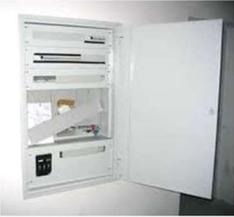
Um eine sichere und ausreichende Stromversorgung zu gewährleisten, baut der Auftragnehmer 10 Stromkreise mit einem Fehlerstromschutzschalter in das Haus ein. (inklusive Prüfbericht). Der Elektroherd, die Geschirrspülmaschine, die Waschmaschine, der Wäschetrockner erhalten jeweils eigene Stromkreise. Die verbleibenden Stromkreise werden für Lichtauslässe und Steckdosen aufgeteilt.
